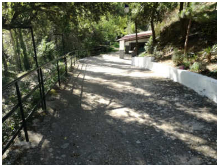
Figura 30. Imagen A: Límite oeste de Casa de la Noguera, se observa el desnivel a la izquierda de la imagen. Al fondo se observa un pequeño puente sobre el arroyo de Roblellano, que discurre al sur de Casa de la Noguera.
